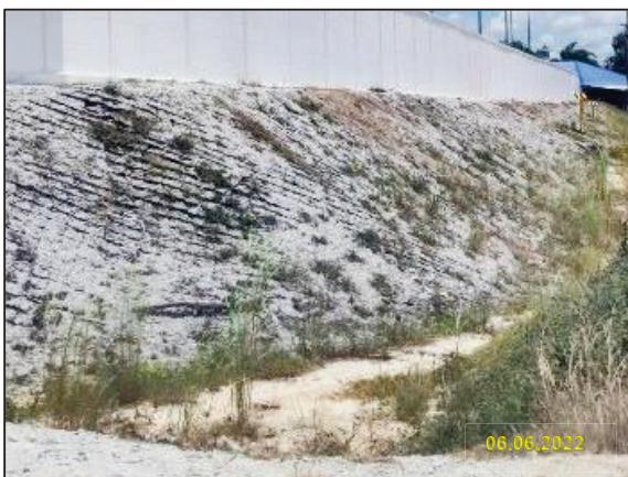
รูปที่ 2-30 การปรับความลาดชันโดยรอบสถานีควบคุมก๊าซฯ TP5MXS ด้านที่ติดกับแนวเขตที่ดินบุคคลอื่น
