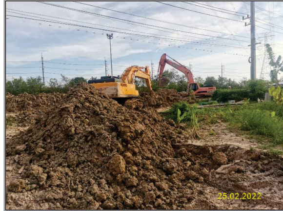
รูปที่ 2-29 การจัดกองดินให้ห่างจากแหล่งน้ำและทางระบายน้ำ
