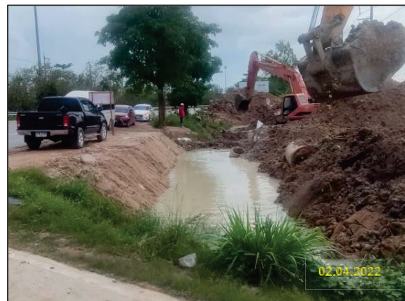
รูปที่ 2-28 การจัดทำทางเบี่ยงเบนทิศทางการไหลของน้ำและการวางท่อลอดถนนทางเข้าชั่วคราว
