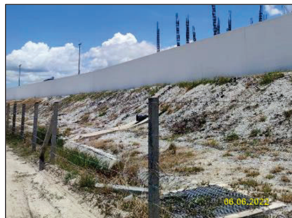
รูปที่ 2-30 การปรับความลาดชันโดยรอบสถานีควบคุมก๊าซฯ TP5MXS ด้านที่ติดกับแนวเขตที่ดินบุคคลอื่น
