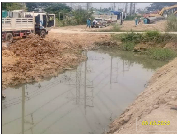
รูปที่ 2-28 การจัดทำทางเบี่ยงเบนทิศทางการไหลของน้ำและการวางท่อลอดถนนทางเข้าชั่วคราว
