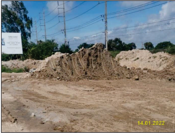
รูปที่ 2-29 การจัดกองดินให้ห่างจากแหล่งน้ำและทางระบายน้ำ
