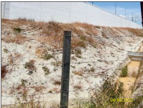
รูปที่ 2-29 การจัดกองดินให้ห่างจากแหล่งน้ำและทางระบายน้ำ
